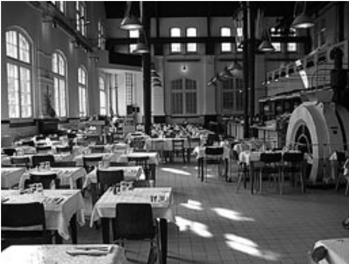
Interieur van het Machinepompgebouw (nu Café Amsterdam), 1897
